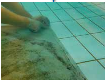
水中ボンド止め作業
