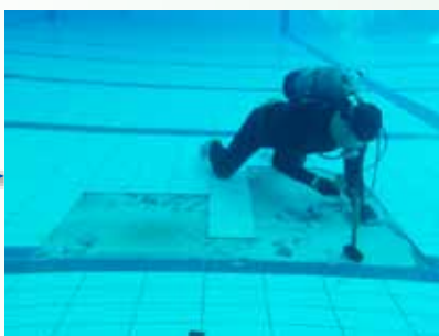
タイル撤去作業
